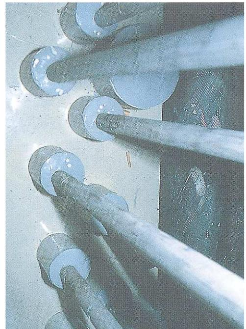
Abschottungssystem für nichtbrennbare ungedämmte Rohrleitungen aus Stahl oder Guss in Wand- und Deckendurchführungen.
