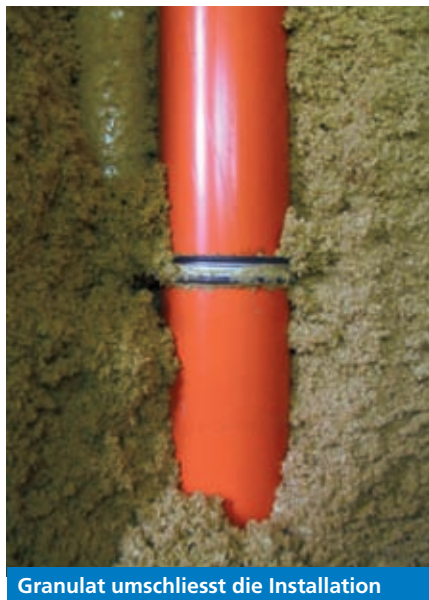
Granulat während der Einblasphase
