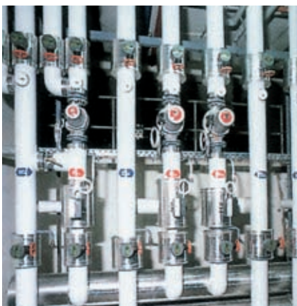
Dämmung mit PVC-Umhüllung
